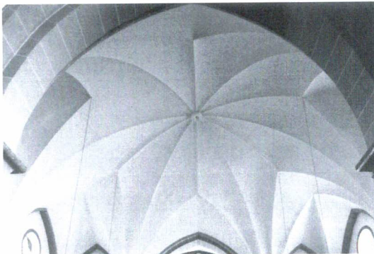
St.-Dionysius-Kirche, Gewölbe des Vorchores, 1993
